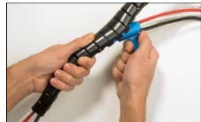
Træk derefter værktøjet gennem Helawrap slangen.
