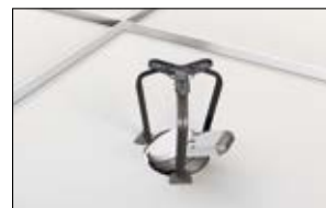
3. Monter downlighten i henhold til producentens vejledning.
