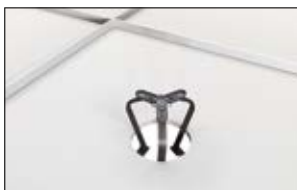
1. Tryk benene sammen og indfør SpotClip-Kit gennem hullet.
