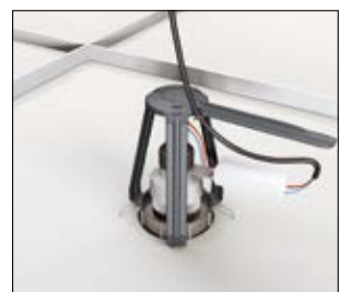
4. Tilslut forsyningen og fastgør ledningen i ledningsholderen.
